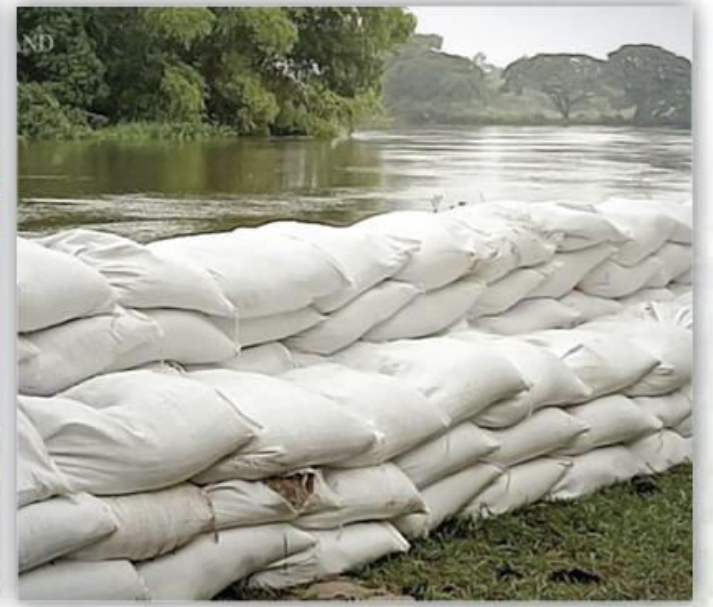
Pembinaan benteng pasir untuk
